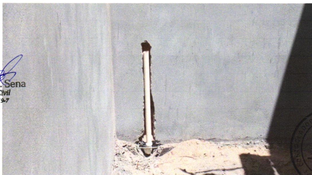
FOTO 10 - (COMPOSIÇÃO REPRESENTATIVA) DO SERVIÇO DE INSTALAÇÃO DE TUBOS DE PVC, SÉRIE R, ÁGUA PLUVIAL, DN 75 MM (INSTALADO EM RAMAL DE ENCAMINHAMENTO, OU CONDUTORES VERTICAIS), INCLUSIVE CONEXÕES, CORTE E FIXAÇÕES, PARA PRÉDIOS. AF_10/2015
