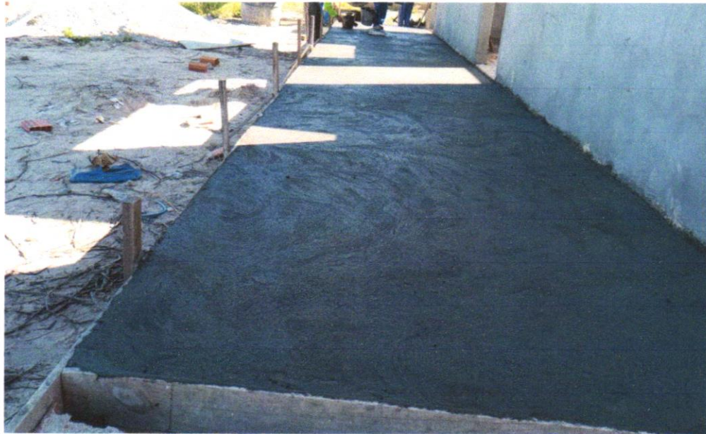
FOTO 05 - EXECUÇÃO DE PASSEIO (CALÇADA) OU PISO DE CONCRETO COM CONCRETO MOLDADO IN LOCO, USINADO, ACABAMENTO CONVENCIONAL, NÃO ARMADO. AF_07/2016
