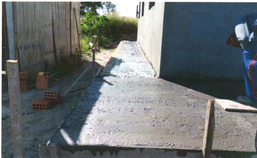
FOTO 06 - EXECUÇÃO DE PASSEIO (CALÇADA) OU PISO DE CONCRETO COM CONCRETO MOLDADO IN LOCO, USINADO, ACABAMENTO CONVENCIONAL, NÃO ARMADO. AF_07/2016
