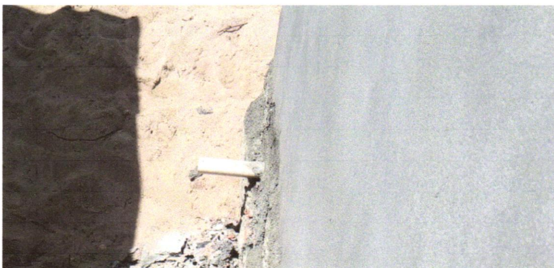
FOTO 14 - (COMPOSIÇÃO REPRESENTATIVA) DO SERVIÇO DE INSTALAÇÃO DE TUBOS DE PVC, SÉRIE R, ÁGUA PLUVIAL, DN 75 MM (INSTALADO EM RAMAL DE ENCAMINHAMENTO, OU CONDUTORES VERTICAIS), INCLUSIVE CONEXÕES, CORTE E FIXAÇÕES, PARA PRÉDIOS. AF_10/2015
