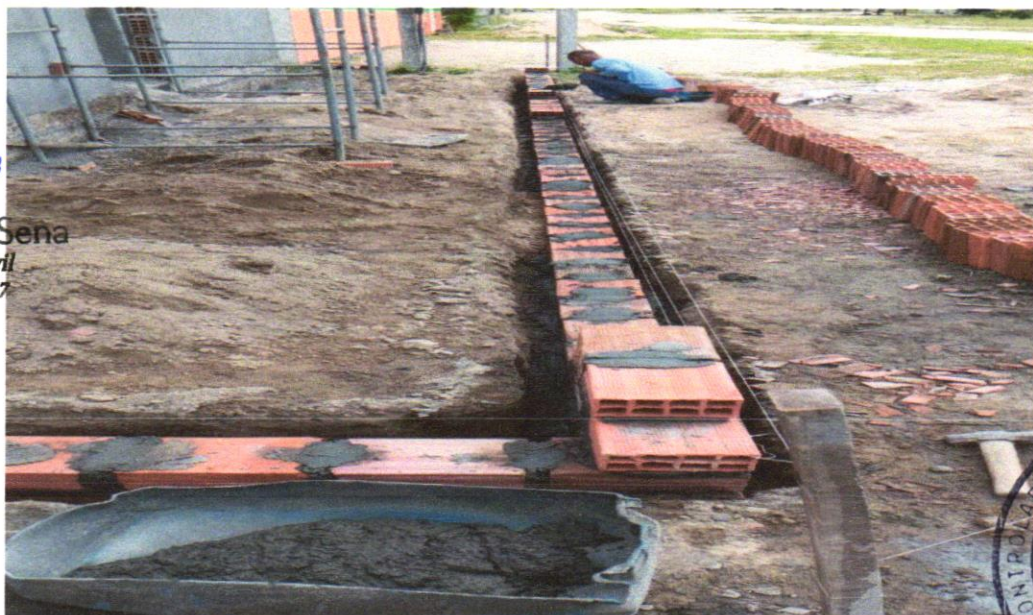
FOTO 02 – ALVENARIA DE VEDAÇÃO DE BLOCOS CERÂMICOS FURADOS NA VERTICAL, DE 9X19X39CM (ESPESSURA 9CM) DE PAREDES COM ÁREA LÍQUIDA MAIOR OU IGUAL A 6M² COM VÃOS E ARGAMASSA DE ASSENTAMENTO COM PREPARO EM BETONEIRA. AF 06/2014
