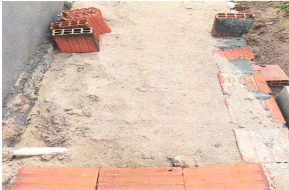
FOTO 03 - ATERRO MANUAL DE VALAS COM AREIA PARA ATERRO E COMPACTAÇÃO MECANIZADA. AF_05/2016
