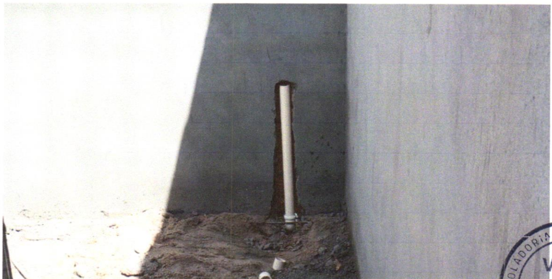
FOTO 12 - TUBO PVC, SÉRIE R, ÁGUA PLUVIAL, DN 100 MM, FORNECIDO E INSTALADO EM RAMAL DE ENCAMINHAMENTO. AF_06/2022
