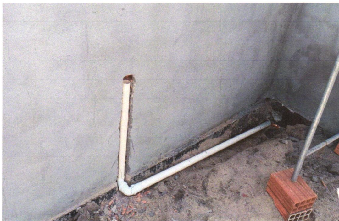
FOTO 09 - (COMPOSIÇÃO REPRESENTATIVA) DO SERVIÇO DE INSTALAÇÃO DE TUBOS DE PVC, SÉRIE R, ÁGUA PLUVIAL, DN 75 MM (INSTALADO EM RAMAL DE ENCAMINHAMENTO, OU CONDUTORES VERTICAIS), INCLUSIVE CONEXÕES, CORTE E FIXAÇÕES, PARA PRÉDIOS. AF_10/2015
