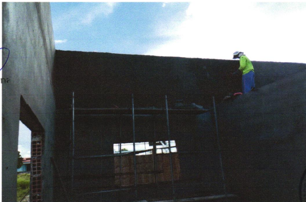
FOTO 16 - MASSA ÚNICA, PARA RECEBIMENTO DE PINTURA, EM ARGAMASSA TRAÇO 1:2:8, PREPARO MANUAL, APLICADA MANUALMENTE EM FACES INTERNAS DE PAREDES, ESPESSURA DE 10MM, COM EXECUÇÃO DE TALISCAS. AF_06/2014
