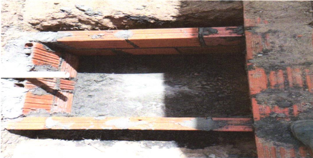
Foto 07 – Caixa de inspeção 0,30 x 0,30 x 0,40m
